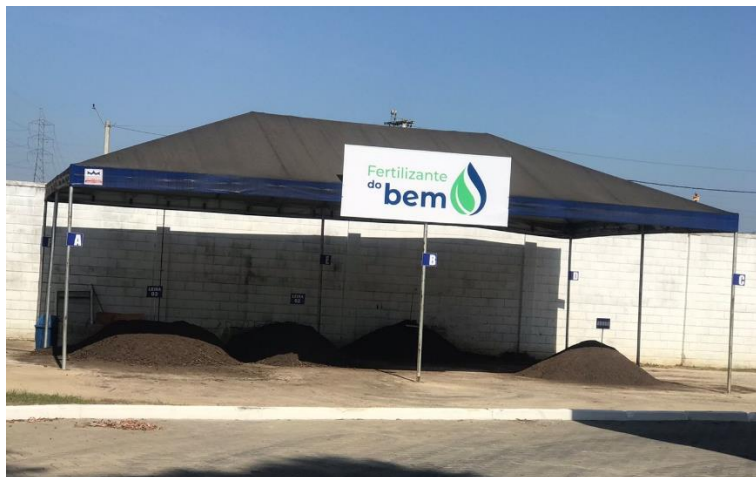
Figura 5: Planta piloto de compostagem na ETE Esplanada
